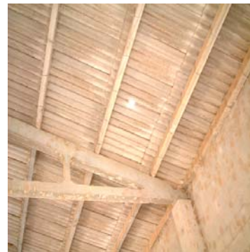
El hueco en el techo sobre la prensa caliente
